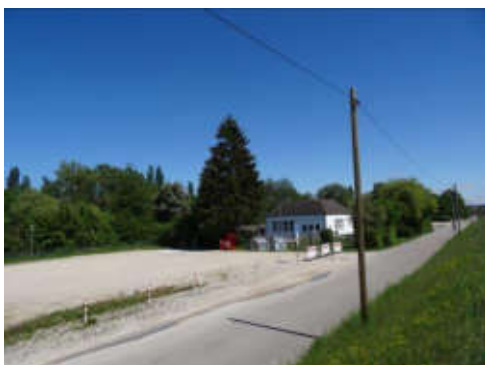
Bestehende Pumpstation im Westen
