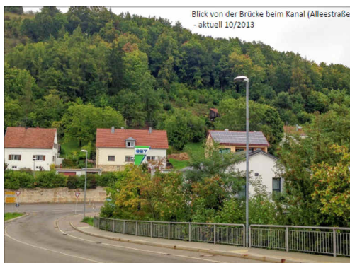
Blick von der Brücke beim Kanal (Alleestraße) Bestand 10/2013
