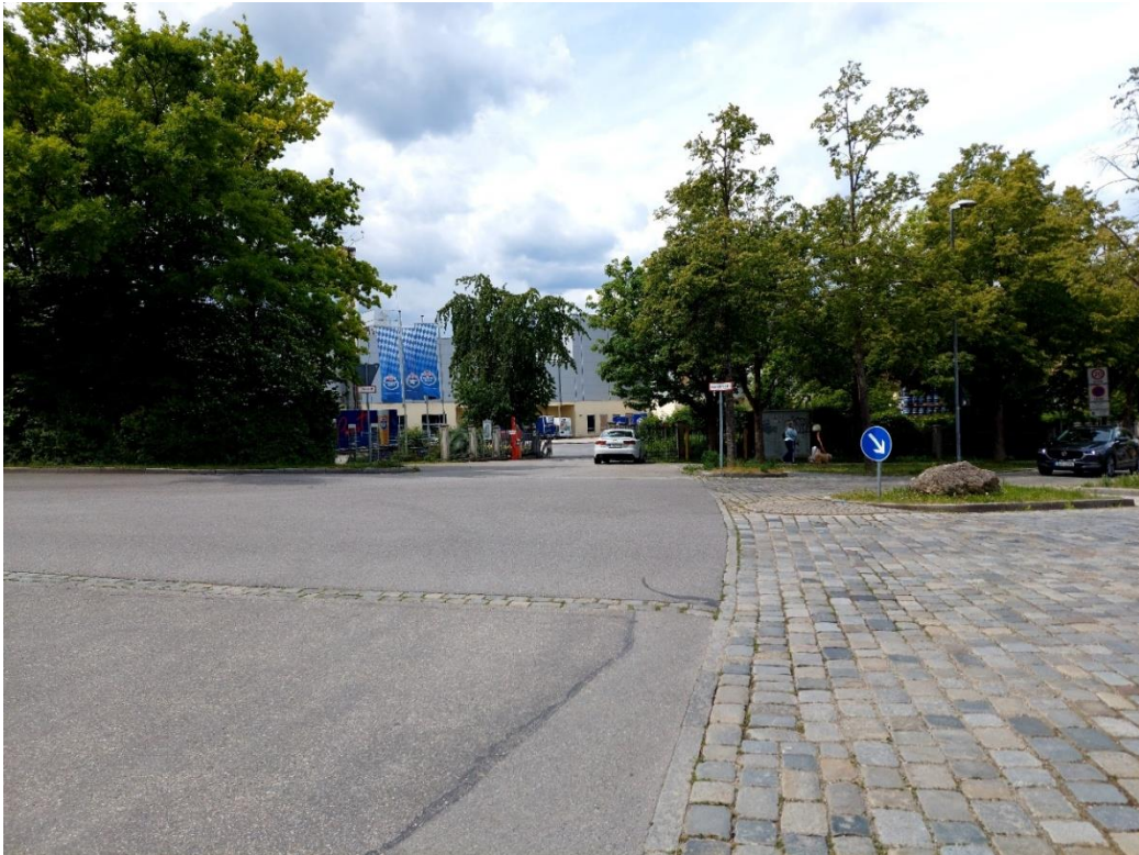
Derzeitiger Zustand außerhalb des Geltungsbereichs – Blick von Osten nach Westen – Zufahrt zum Gelände
