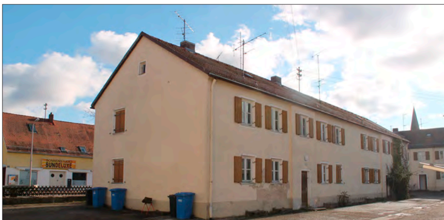
Dieses Haus prägte jahrzehntelang die Bauersiedlung.
