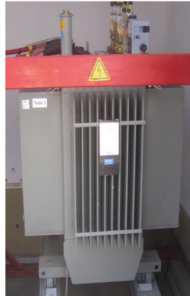
Abb. 4: Öltransformator einer Freiflächenphotovoltaikanlage (Bildquelle: LfU)
